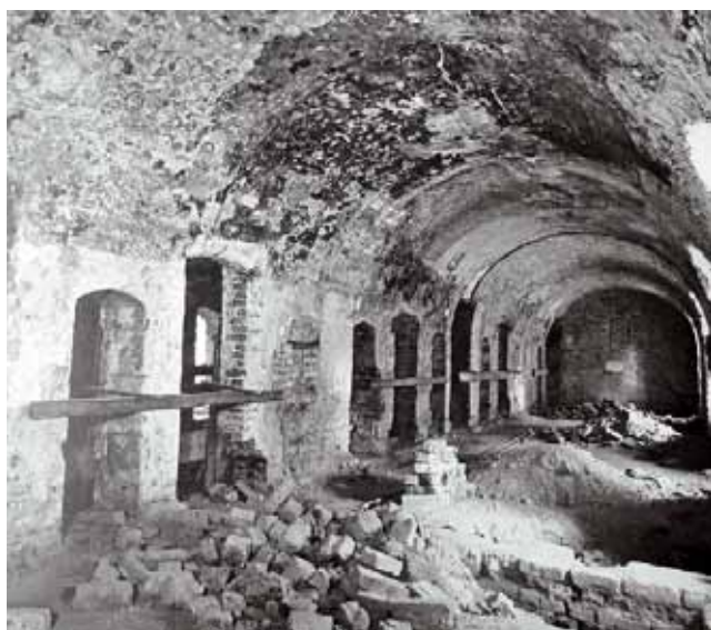
Dormitoriet i norra längans övervåning, sensommaren 1956. Här syns södra tunnvalvet med ursprungliga dörröppningar till nunnornas sovceller och högre sentida dörröppningar till sjuksalar.
